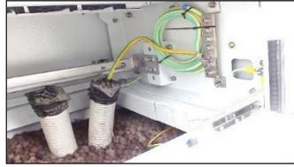
Bild 13: Erdungskabel 16mm<sup>2</sup> im Schutzrohr
