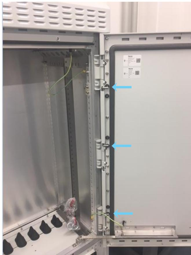
Bild 15: Bolzen der Türe und Scharniere vom Gehäuses
